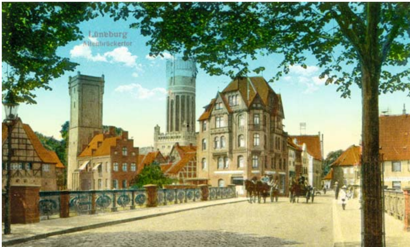
Der alte und der neue Wasserturm auf einer Ansichtskarte von 1911.
