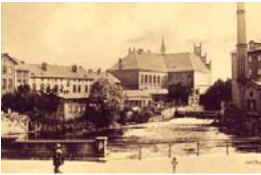
Blick über die Ilmenau auf die Rückseite der Häuser an der Willy-Brandt-Straße. Ansichtskarte um 1907.
