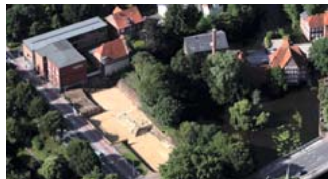
Luftbild der Museumsbaustelle im Juli 2011.
