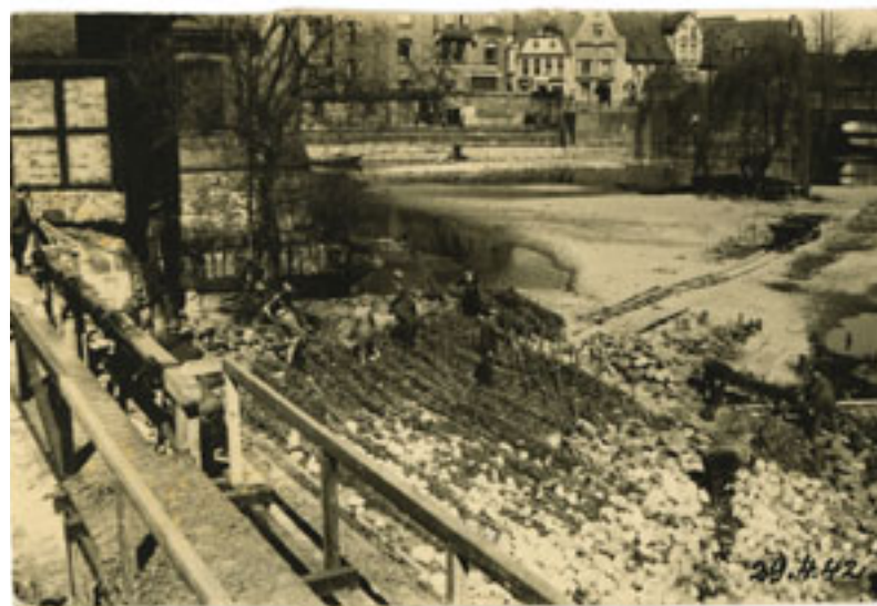
29. April 1942: Der Ablauf des Wehrs beim Ratswasserwerk wird mit Buschwerk und Steinen neu verschient.
