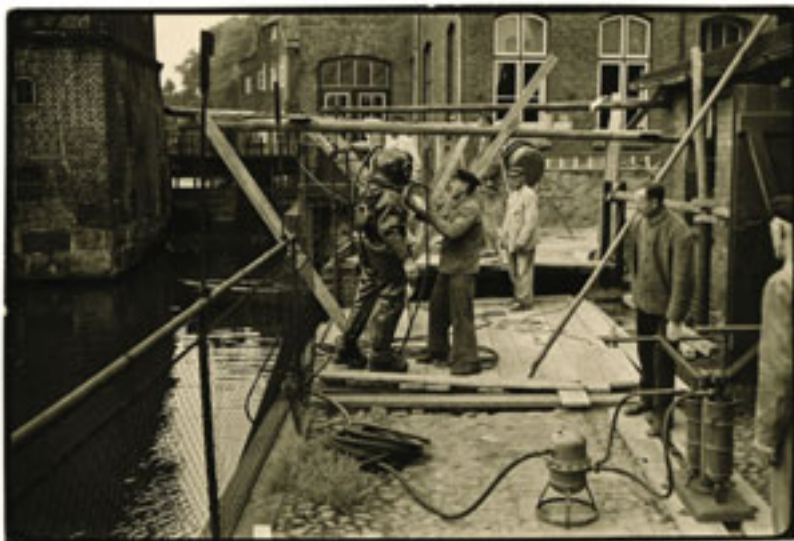
Bevor 1942 die Flutschäden des Vorjahres beseitigt werden, untersucht ein Taucher die Uferbefestigung beim Ratswasserwerk.
