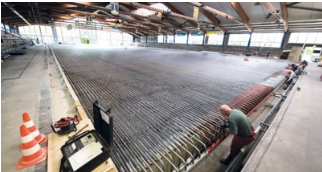
Bei den Renovierungsarbeiten des Adendorfer Eisstadions wurde die gesamte Fläche abgetaut.
