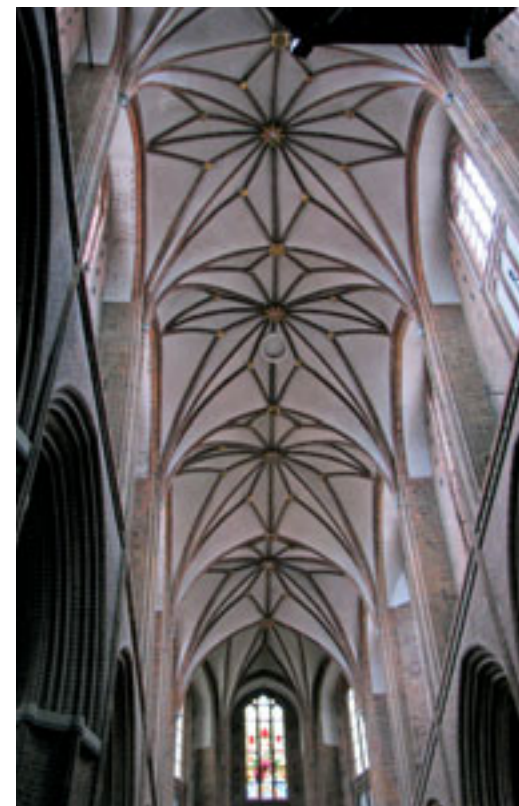
Das Sternengewölbe an der Decke des 28 Meter hohen Mittelschiffes.
