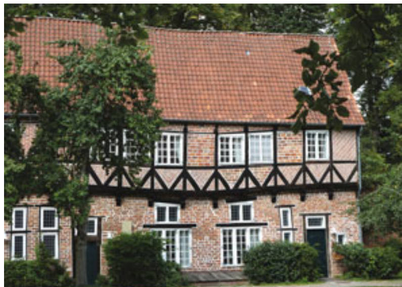
„Pfusch am Bau“: Das Pfarrwitwenhaus Auf dem Michaeliskloster
