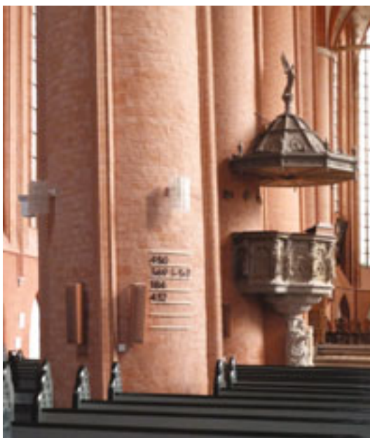
Eine Säulenreihe der St. Michaeliskirche, von Senkungsschäden heimgesucht und somit sichtlich aus dem Lot geraten
