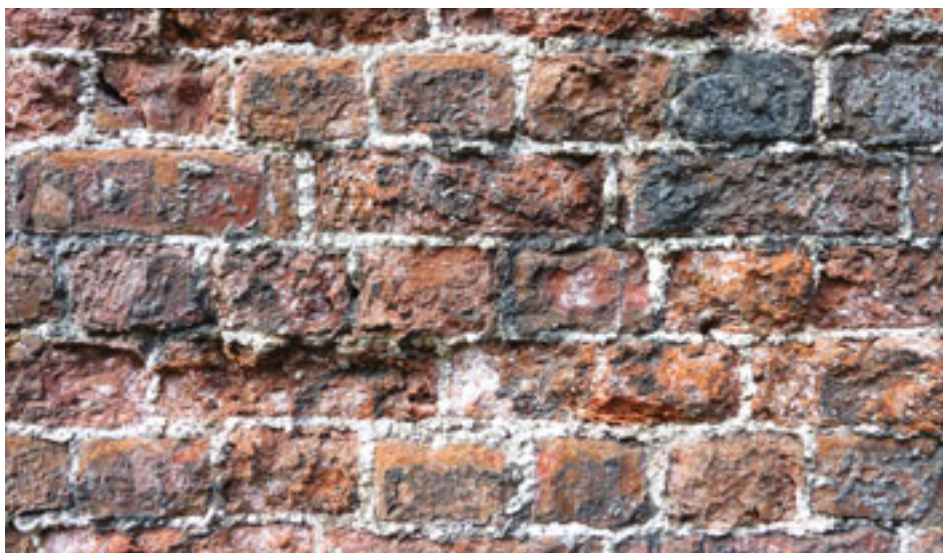
Hinter der Bardowicker Mauer sieht man schlecht gebrannten Gipsmörtel zwischen den Steinen herausquellen. Weil er nicht abgebunden hat, fühlt er sich an der Luft getrocknet wie Pulver an. Der Regen wird es mit der Zeit abspülen
