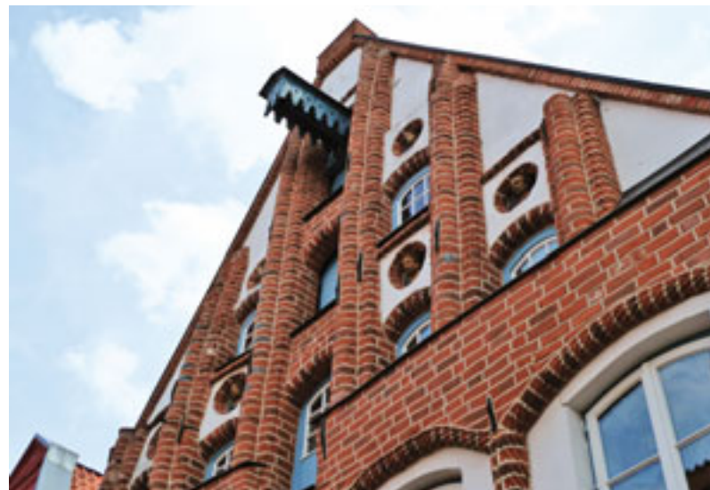
Der gebogene Treppengiebel des stattlichen Hauses Auf dem Meere / Untere Ohlingerstraße
