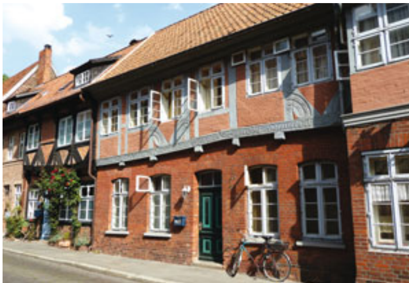
Die Eichenbalken an diesem Haus in der Reitenden-Diener-Straße sind krumm gewachsen
