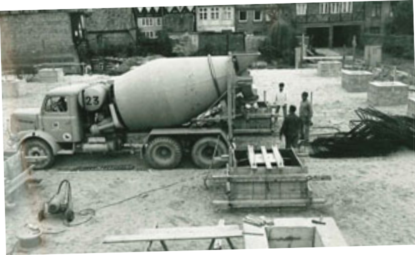
links: Bauarbeiten am Parkhaus Vierorten (heute: City Parkhaus) rechts: 1990 wurde „Happy-Beton“ gegründet
