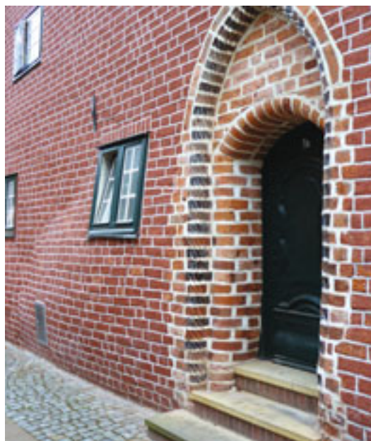
Das Backhaus Waagestraße 1b war für Franz Krüger das Schulbeispiel für die Treibwirkung des Lüneburger Gipsmörtels
