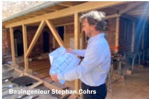
Die Wände scheinen zu schweben. Die Last ruht auf Holz- und Stahlkonstruktionen.
