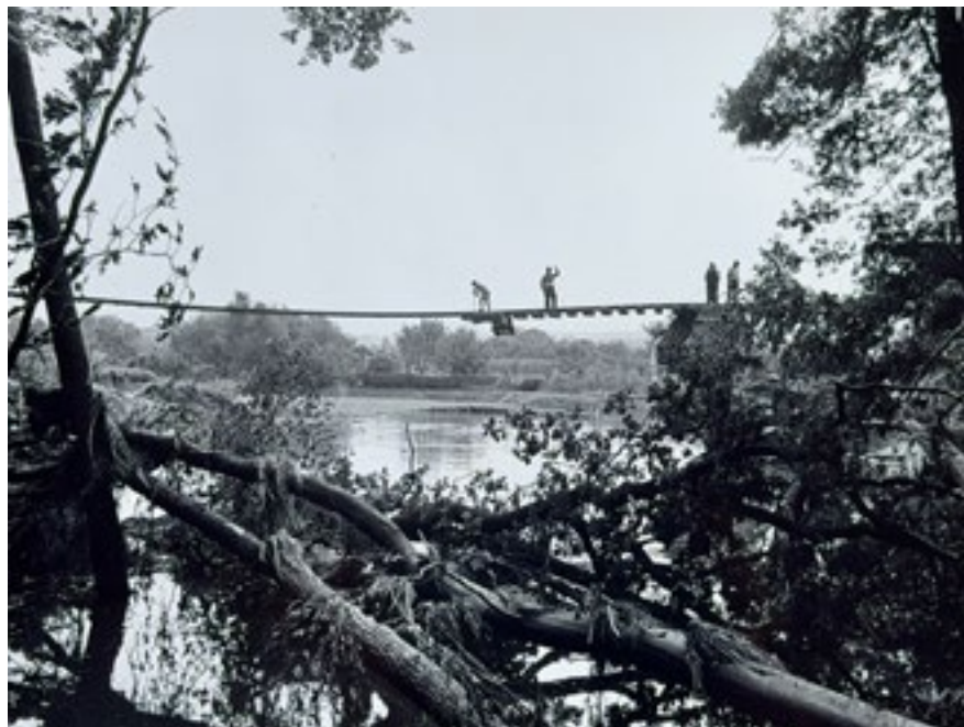
Links: Blick von der Bruchstelle über verwüstete Äcker und Wiesen Richtung Erbstorfer Landstraße. Rechts: Die Bahngleise der Lübecker Bahnlinie wurden zur Hängebrücke; der Bahndamm wurde durch die Gewalt des Wassers weggespült.
