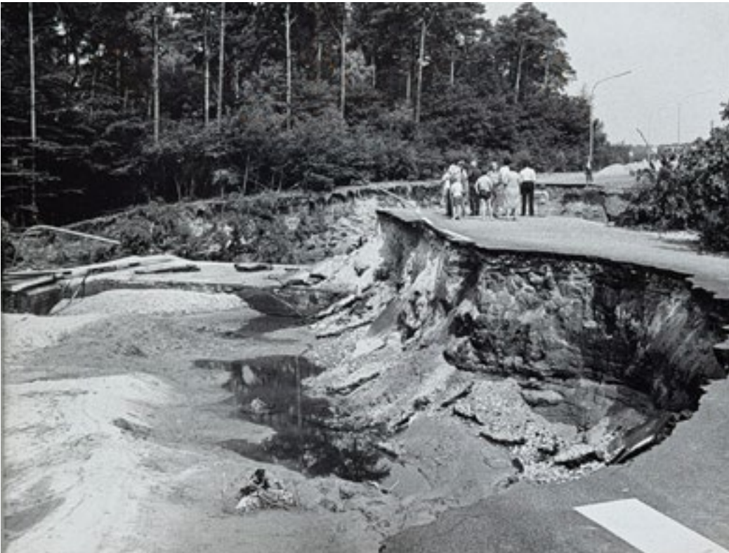
Der Lüner Kreisel wurde total zerstört; die Straße war nicht mehr befahrbar.
